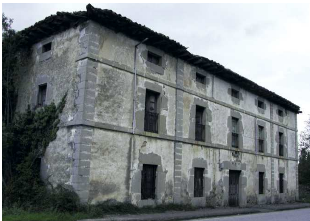
Escuela de la extinguida Fundación "Ortiz de Taranco" de Villanueva de Mena, construida en la segunda mitad del siglo XIX, cuya estructura y cubierta se restaurará con cargo al presupuesto de 2019.
