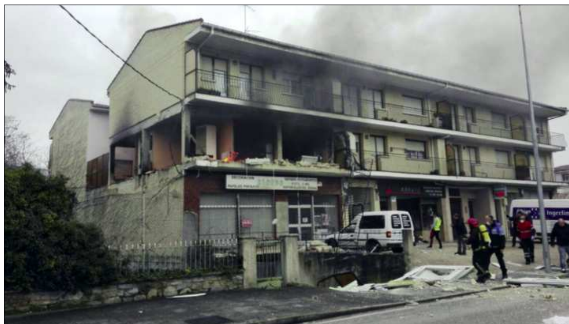
Bloque de viviendas afectado por la explosión de gas ocurrida el 14 de febrero de 2018.
