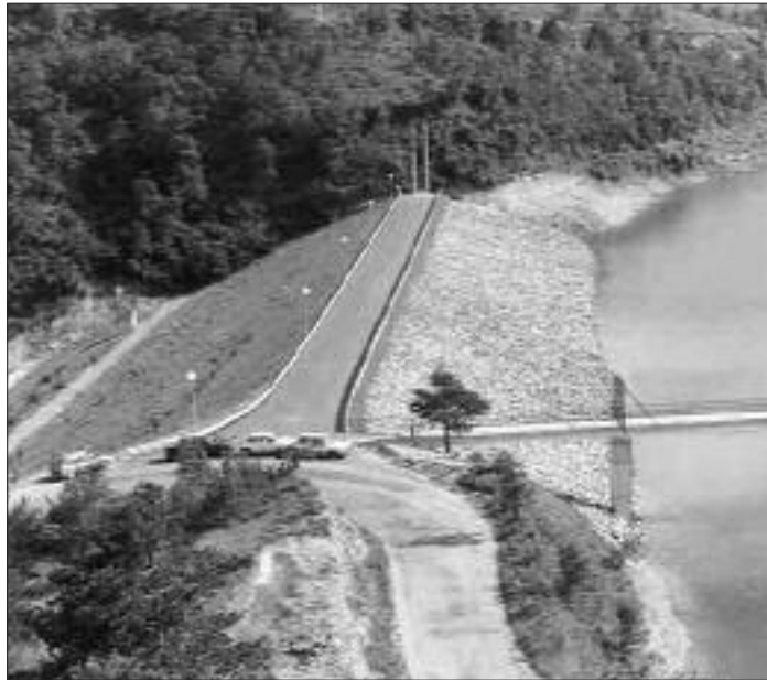
▶ Presa de Arceniega
