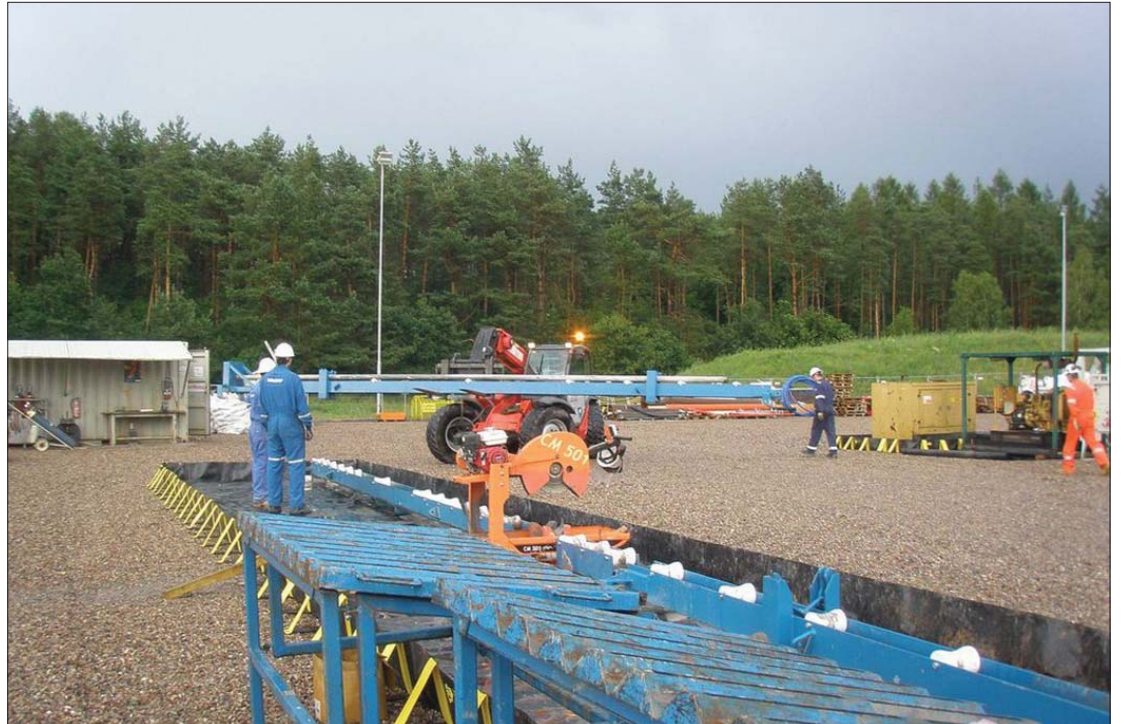
Trabajos en un proyecto de exploración de gas pizarra cerca de Gdansk, Polonia.
