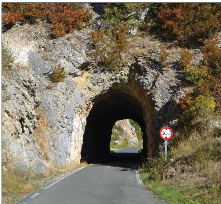
Justo debajo del Túnel de Cereceda se encuentra la Fuente
