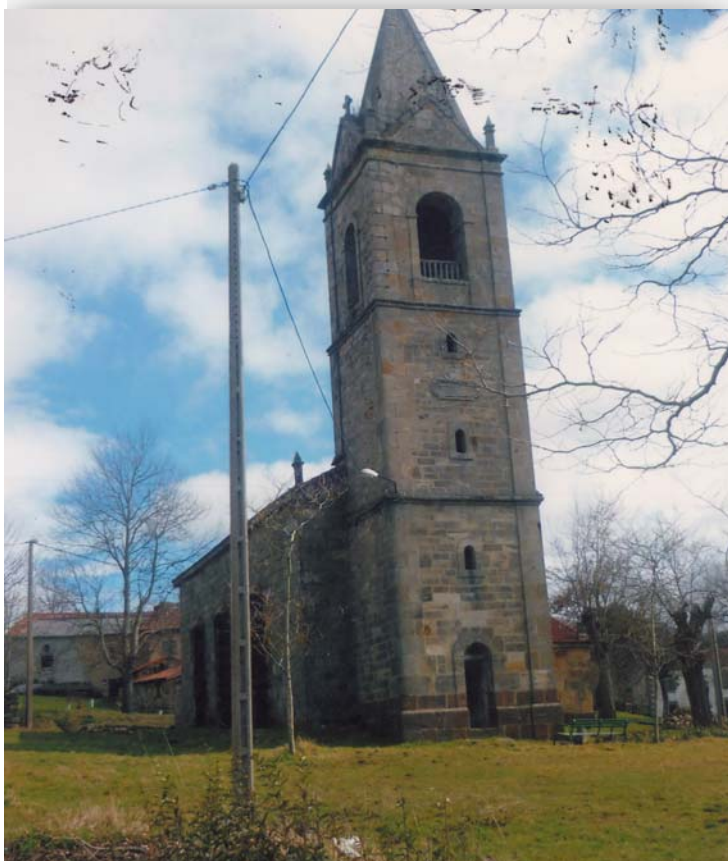
Herbosa. Torre campanario de la iglesia nueva
