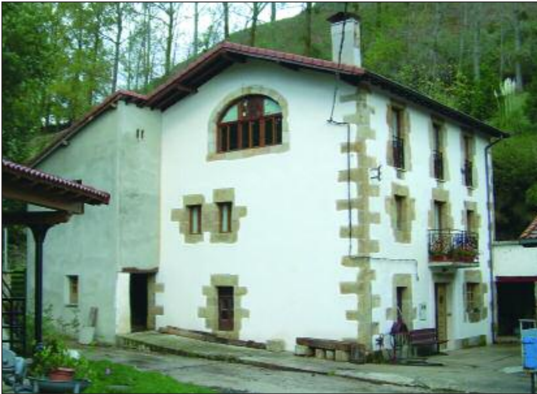
► Edificio que guarda la instalación y máquinas
