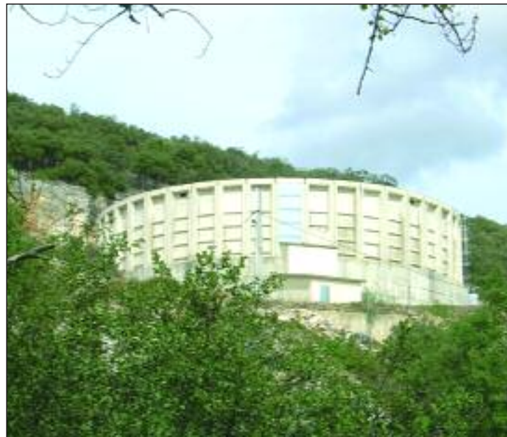
► Depósito de aguas de consumo en Ciguenza
