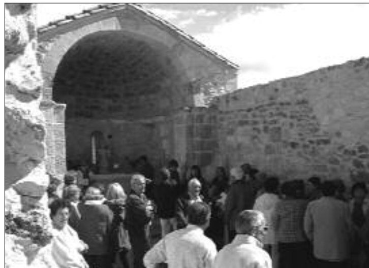
Estado en que ha quedado la ermita de Sobrepeña después de la intervención del cantero David López
