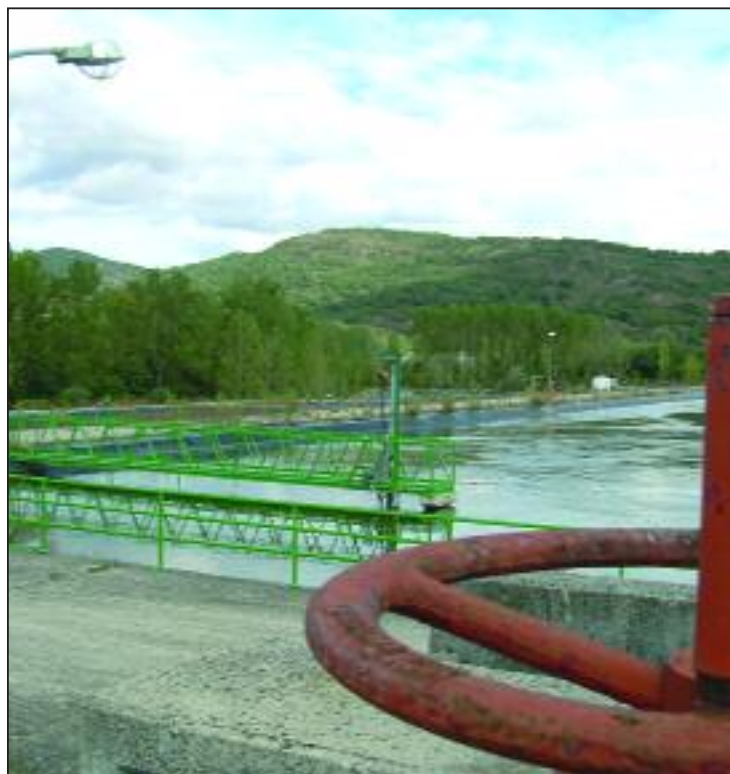
► Estación depuradores de aguas residuales de Bocos
