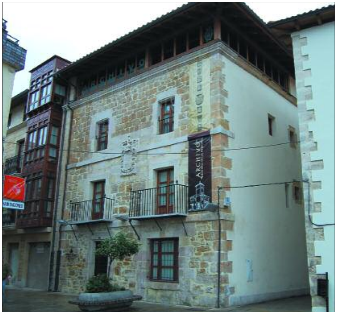
► Edificio que alberga el Archivo Histórico de Las Merindades
