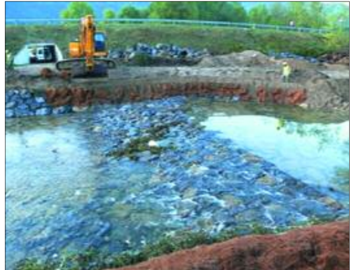
► Trabajos de limpieza y drenaje en el cauce del Cadagua
