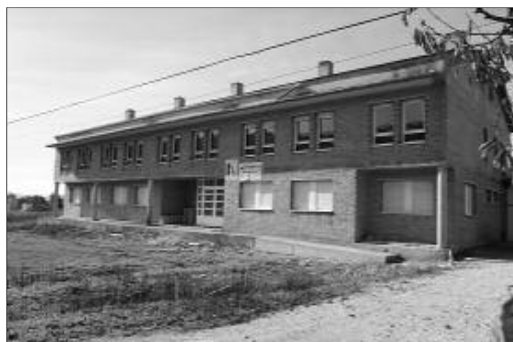
► Estado en que se encuentra la Residencia
