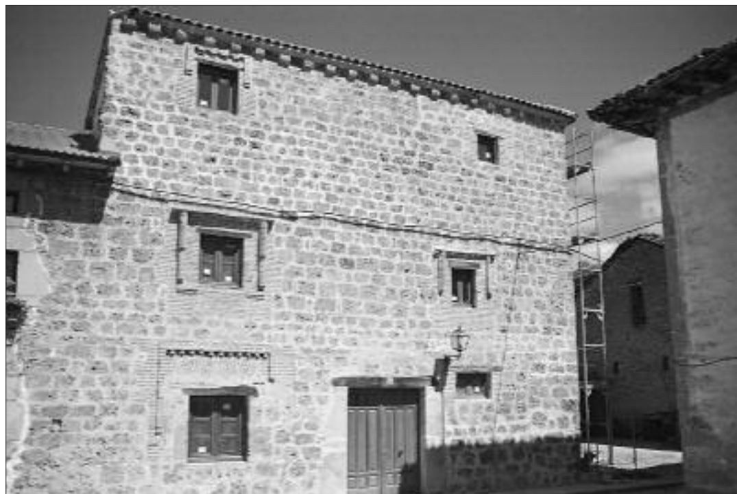
► La fachada recién restaurada conserva la presencia original
