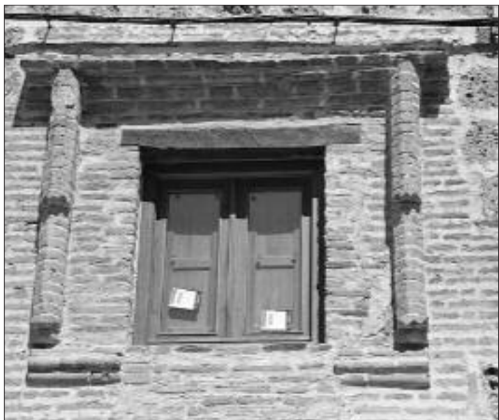
► Ventana mudejar en la fachada
