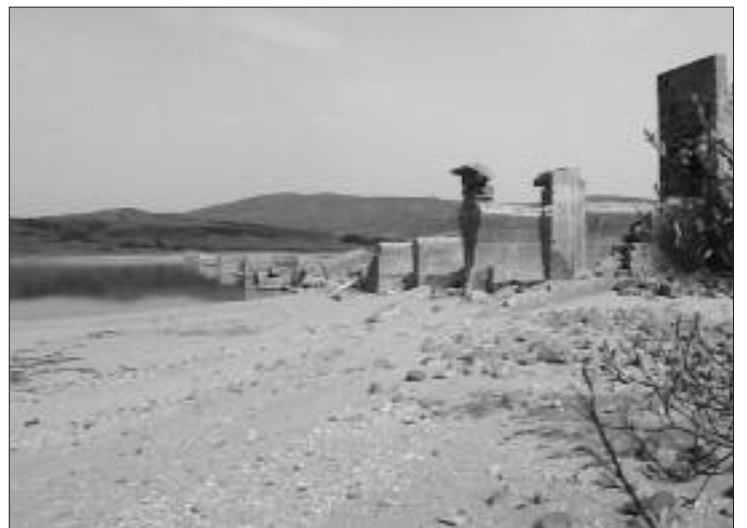
▶ Restos del puente que unía Arija con La Población y que se desplomó cuando estaba a punto de ser inaugurado por el general Franco.
