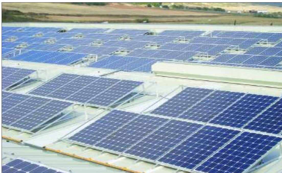
► Instalación fotovoltaica en la cubierta de una nave
