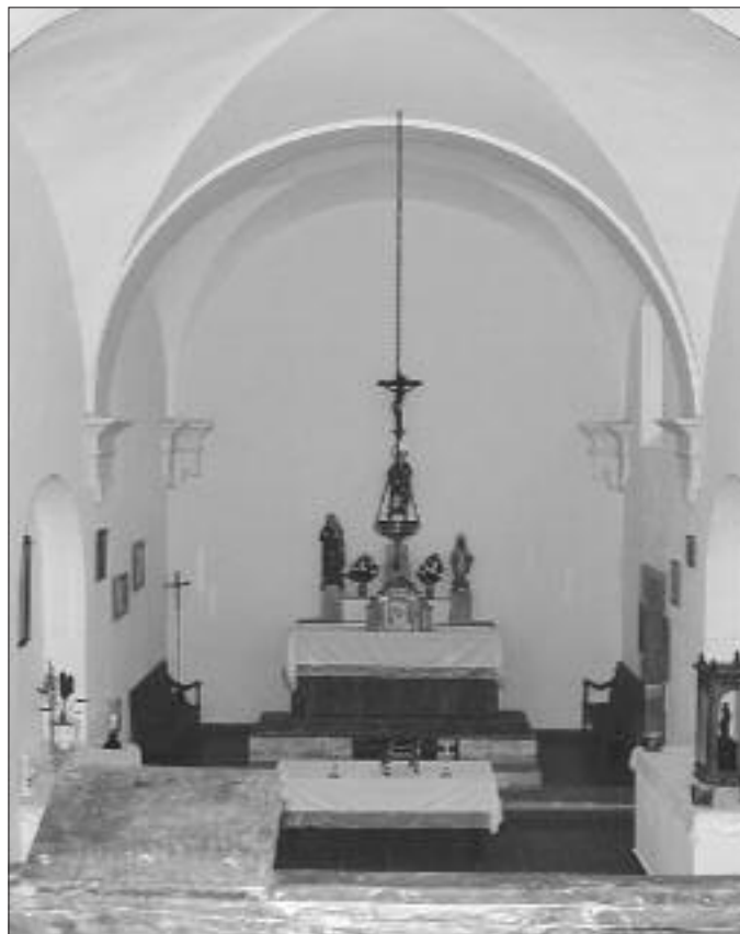
► Las obras han recuperado la nave del templo.
