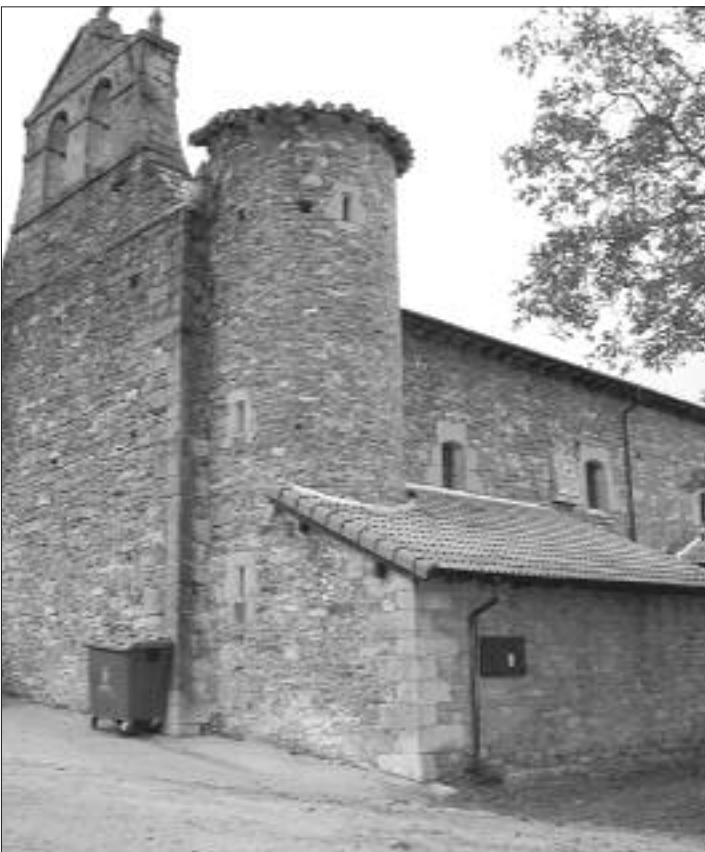
► Actuaciones en las cubiertas.
