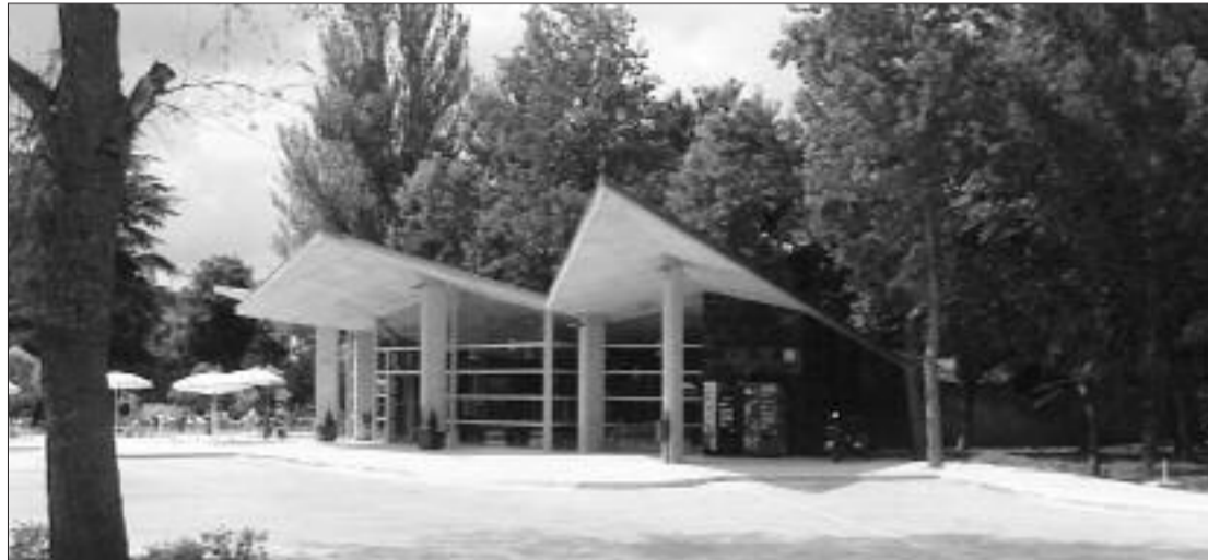
► Nueva estación de autobuses de Villarcayo
