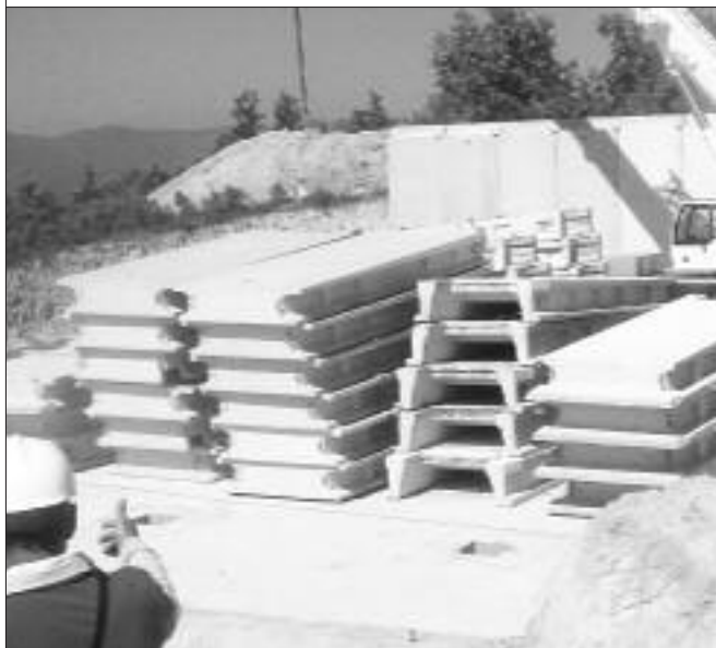
► Obra del depósito de agua
