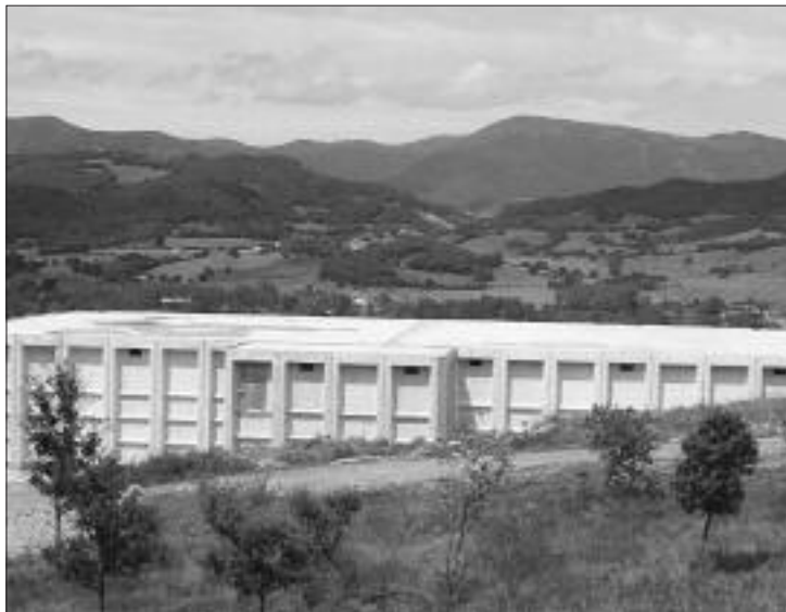
► El nuevo depósito de agua de Villasana.
