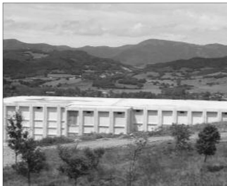
► El nuevo depósito de agua de Villasana está a pleno funcionamiento
