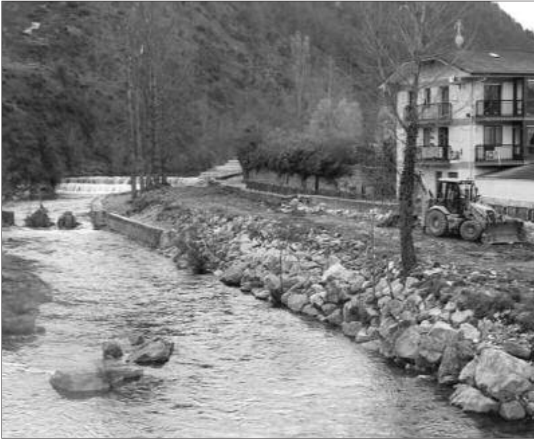
► Las máquinas trabajan en las obras del río Trueba en Espinosa de los Monteros
