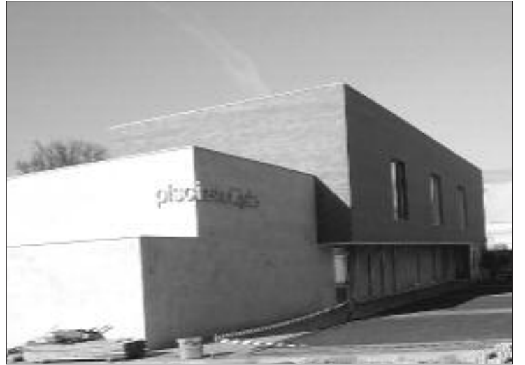
► La instalación está solo a falta de retoques
