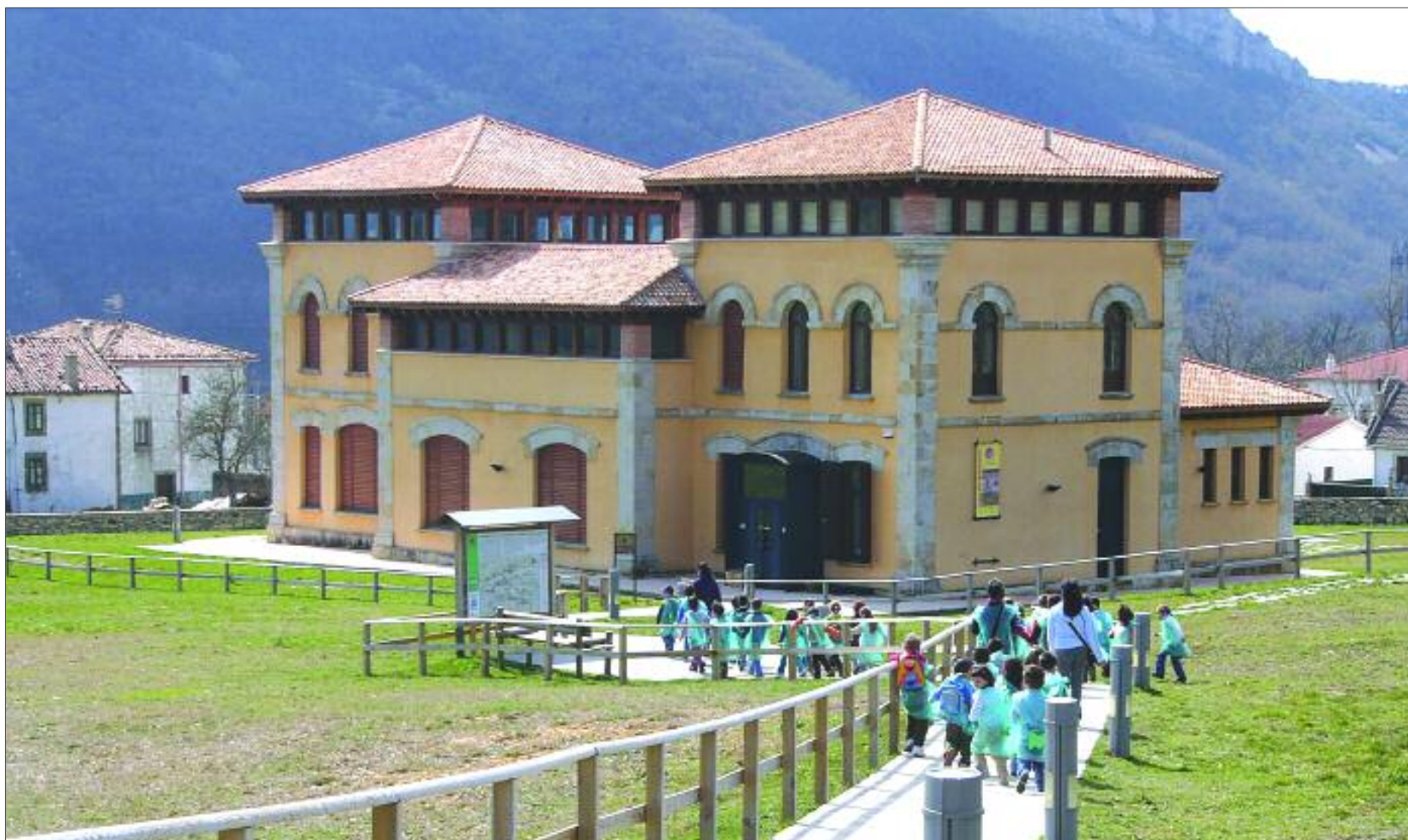
► Edificio en Quintanilla del Rebollar que alberga las instalaciones
