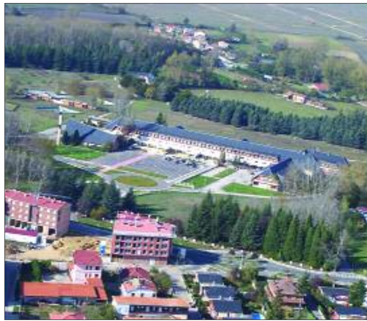
► Vista de la residencia
