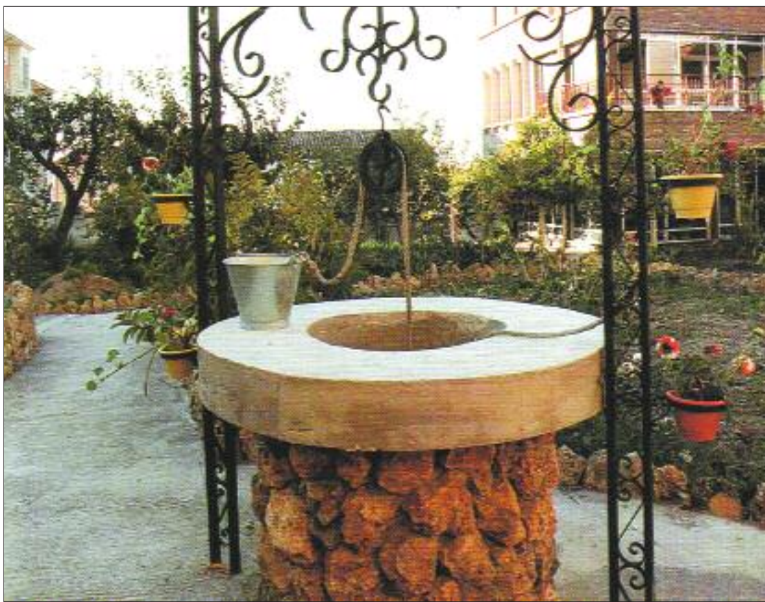
► Pozo construido en 1988 en la huerta del Convento
