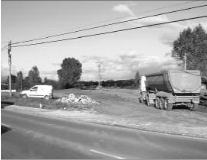
► Movimiento de tierras en la zona de Horna de la Ronda de Villarcayo
