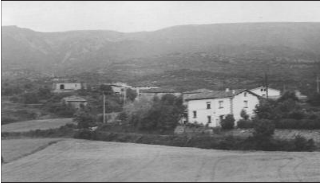
► El acceso a Rufrancos será reparado
