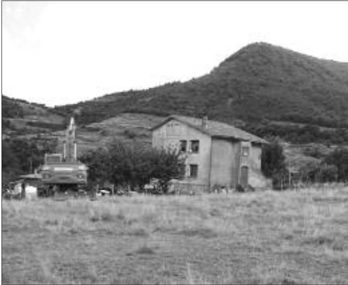
► Una máquina retro trabajando en las catas del suelo
