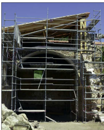
La cubierta de la Cilla se encuentra prácticamente terminada.
