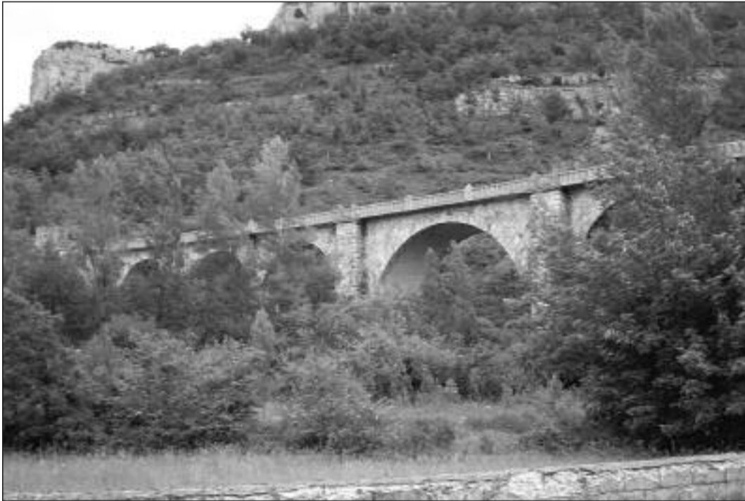
► Puente-Viaducto con 9 arcos de 12 metros y uno de 20 que salva el río Nela cerca de Santelices
