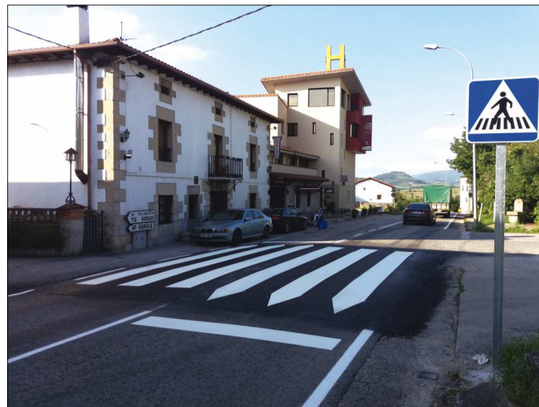
Nuevo paso de cebra en Mercadillo, unión de establecimiento de restauración con aparcamiento, báscula y apeadero FEVE.
