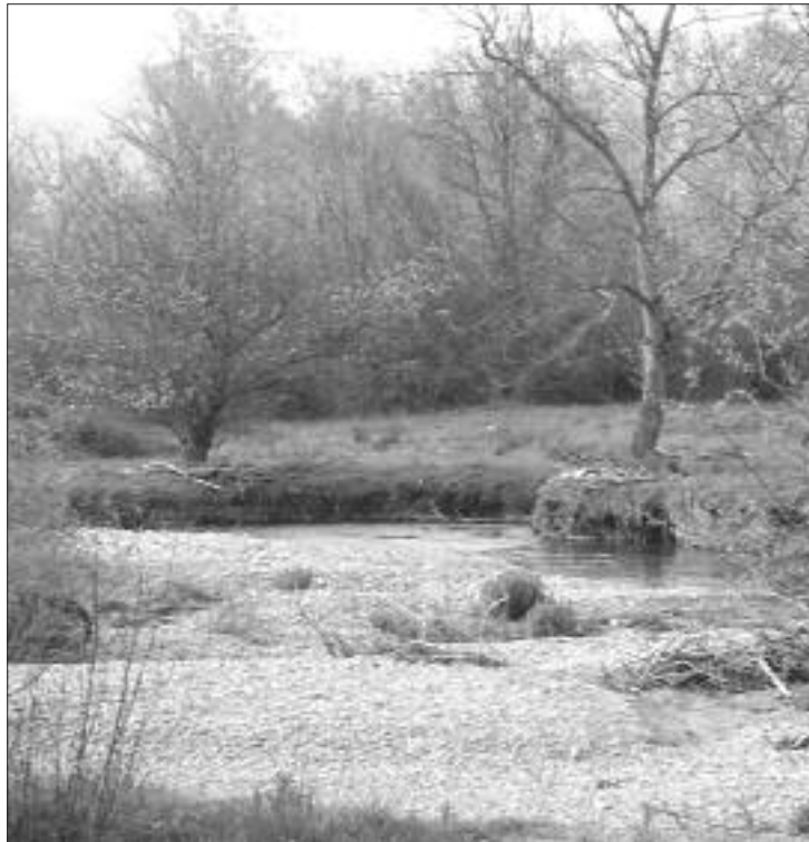
► La intervención de la CHN busca resolver los problemas de degradación de las márgenes del Cadagua en el Valle de Mena
