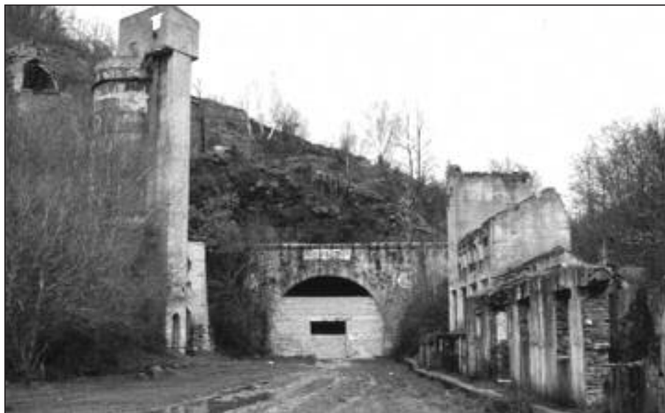
► Entrada al túnel de La Engaña
