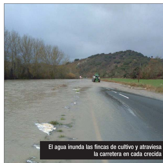
Estado del cauce a su paso por Torres
