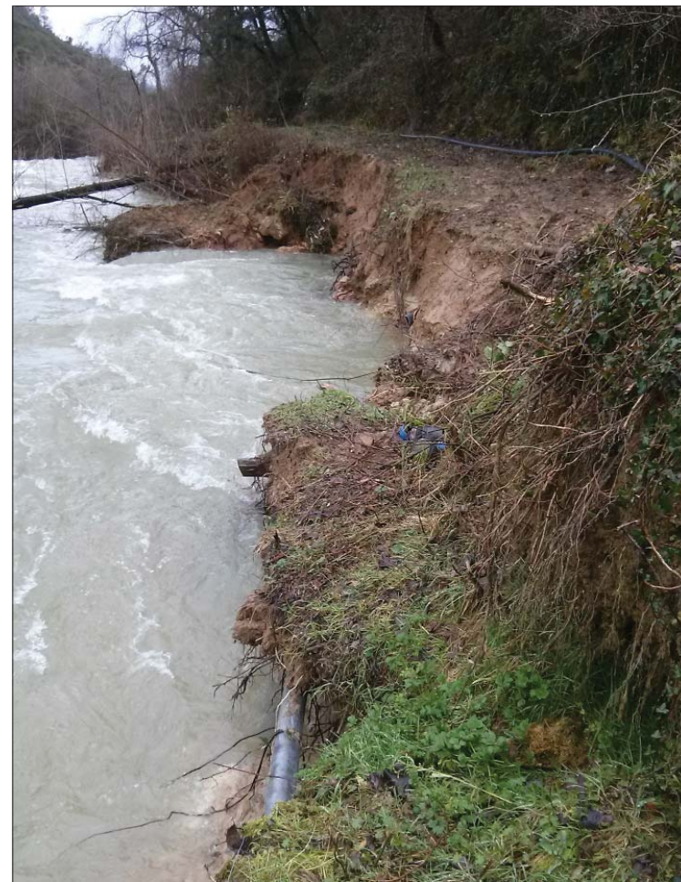
Aspecto con el que ha quedado la red general de abastecimiento a Entrambasaguas
