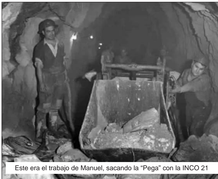
Trabajado en el avance del túnel. Primero se excavaba la parte superior, que llamaban "el avance", después se ensanchaba por arriba hasta conseguir el diámetro. Luego cavaban hacia abajo hasta llegar al piso. recordemos que su anchura es de 8 metros y su altura de 6,5 metros.
