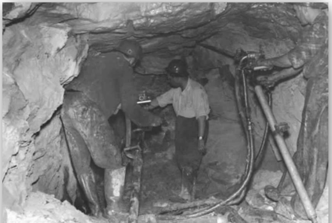
Trabajado en el avance del túnel. Primero se excavaba la parte superior, que llamaban "el avance", después se ensanchaba por arriba hasta conseguir el diámetro. Luego cavaban hacia abajo hasta llegar al piso. recordemos que su anchura es de 8 metros y su altura de 6,5 metros.
